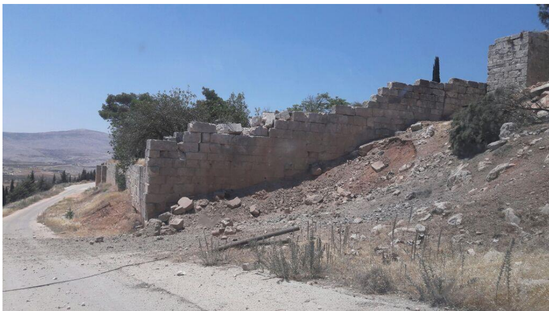
الركن الشمالي الشرقي (الصورة مواجهة للجنوب)
