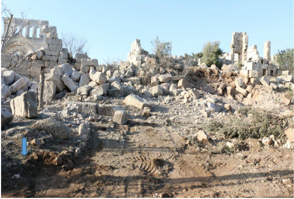
أضرار جسيمة تشمل انهيار وتكسر أحجار البناء (الصورة مواجهة للشمال الشرقي)
