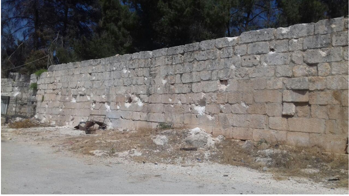
أضرار لحقت بالجدار الخارجي بسبب الشظايا (الصورة مواجهة للجنوب الغربي)
