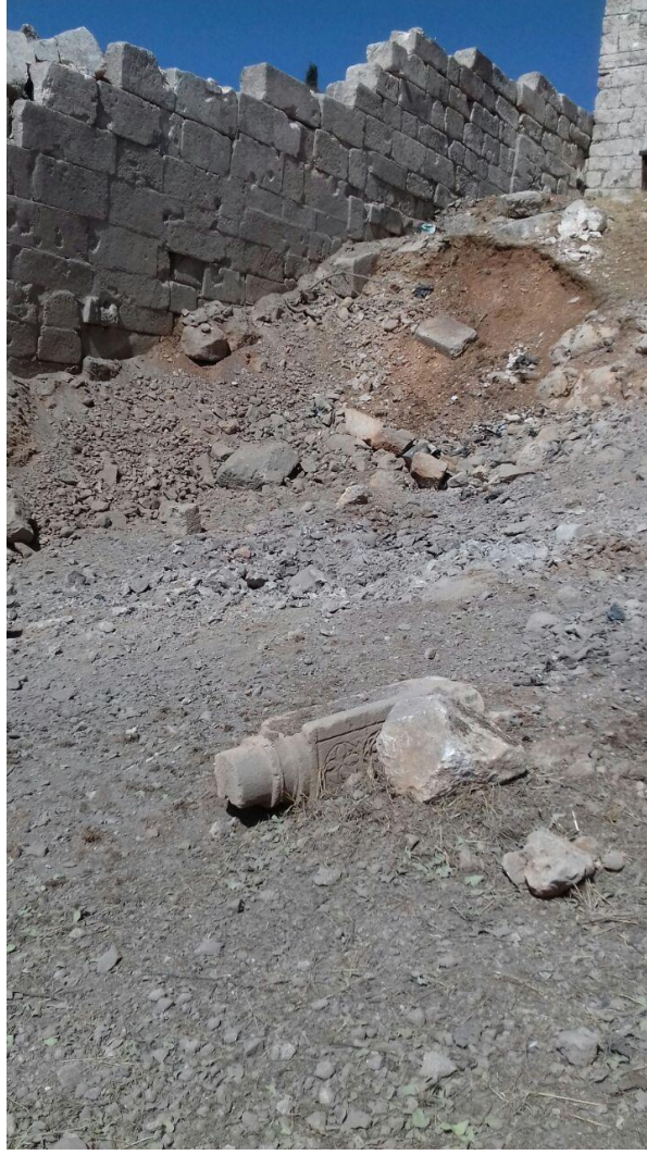
الجدار الخارجي من الجهة الشمالية الشرقية
