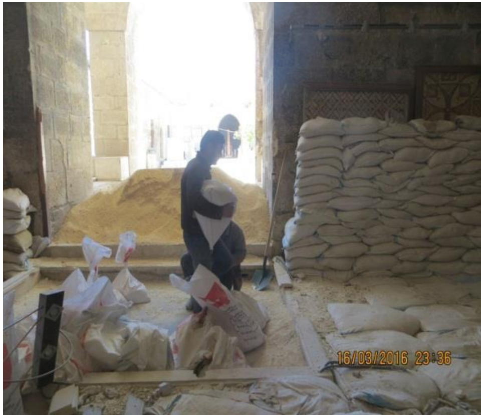
رص أكياس الرمل أمام قطع الفسيفساء لحمايتها
