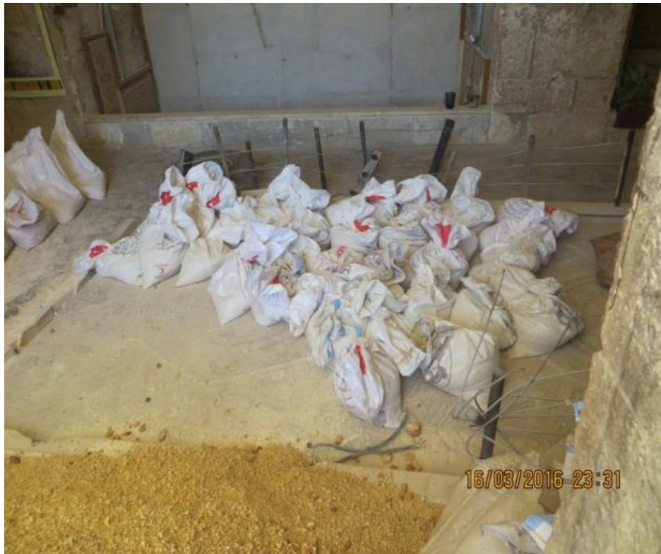
تحضير أكياس الرمل لحماية الفسيفساء
