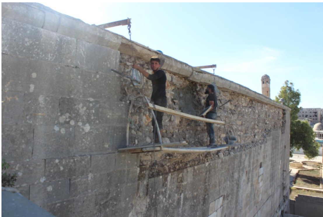
اعمال تدعيم الجدار من الجهة الشمالية
