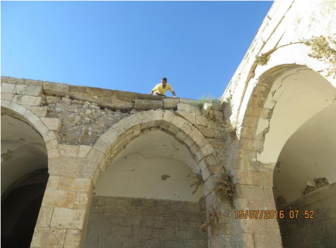
تأشير الحجارة التي يجب فكها والمعرضة للانهييار
