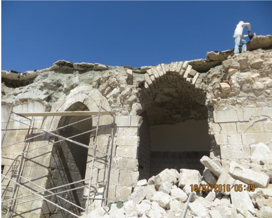
أعمال زريقة لمكان الضرر وتدعيم الأماكن التي تتعرض لضرر بفعل العوامل الجوية
