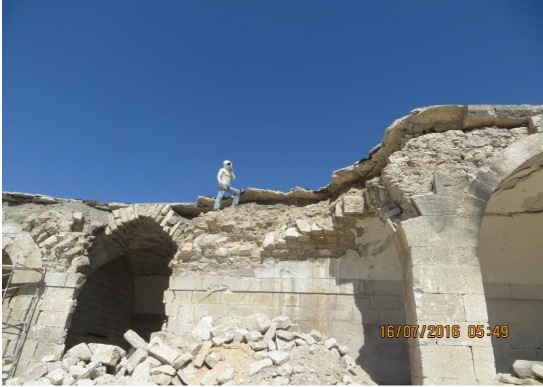
أعمال زريقة لمكان الضرر وتدعيم الأماكن التي تتعرض لضرر بفعل العوامل الجوية
