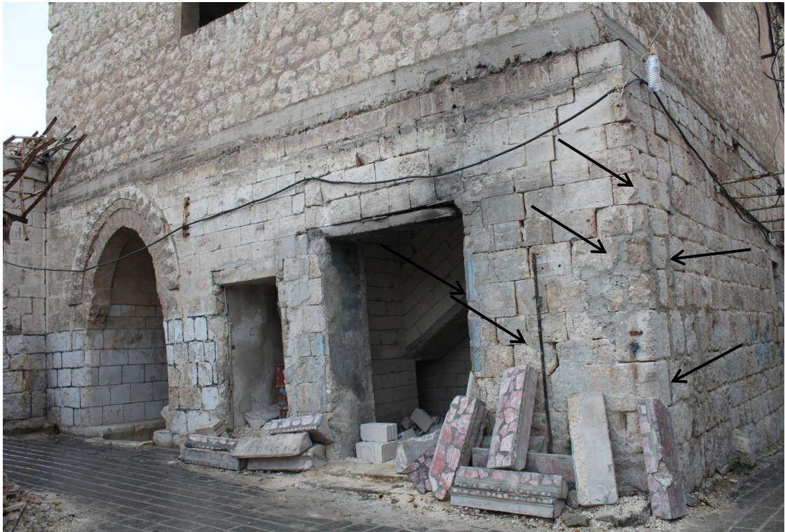
صورة للزاوية الشمالية الشرقية من الخارج وتظهر التشققات فيها
